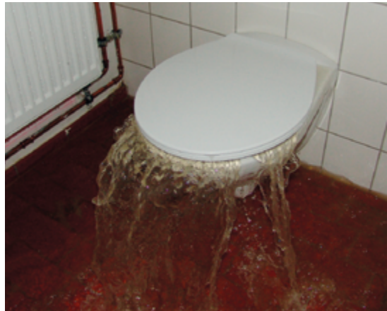
Abb.21: Überlaufende Toilette durch Kanalrückstau
