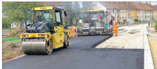
Asphaltarbeiten am 4.5.2022 (Asphalttragschicht), alle Fotos: Gemeinde Memmeldorf
