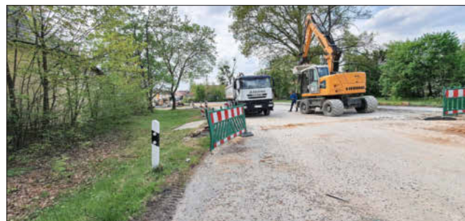
Vor der Asphaltierung, Foto: besc
