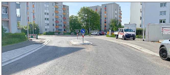
Gundelsheimer Straße / Einmündung Schlesienstraße, von Gundelsheim
