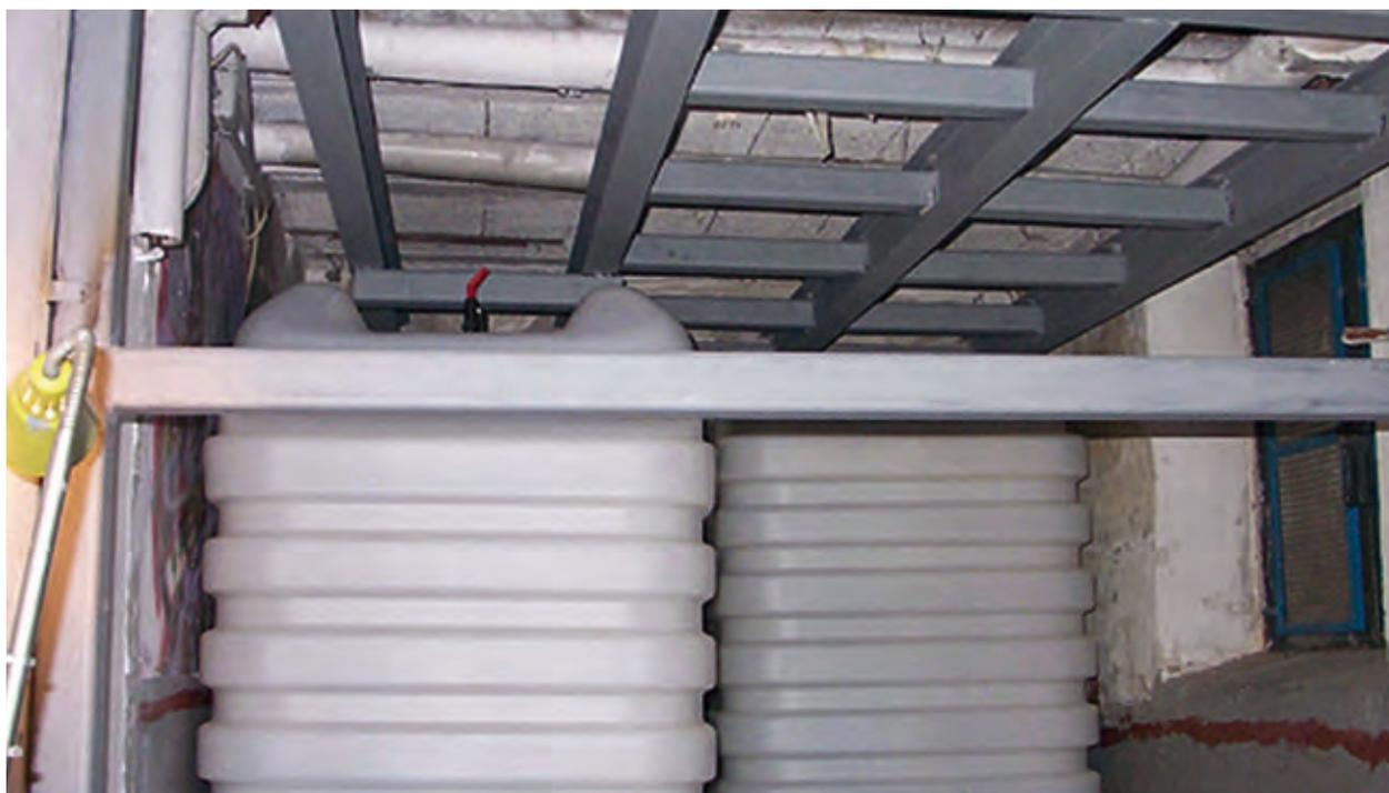
Heizöltankanlage mit Auftriebssicherung
