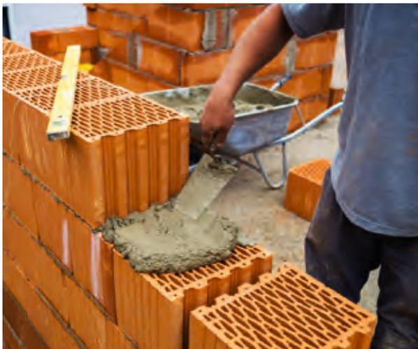
Mauerwerk aus Hochlochziegeln mit geringer Rohdichte
