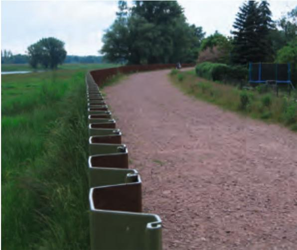
Hochwasserschutzwand mit Stahlpundwand
