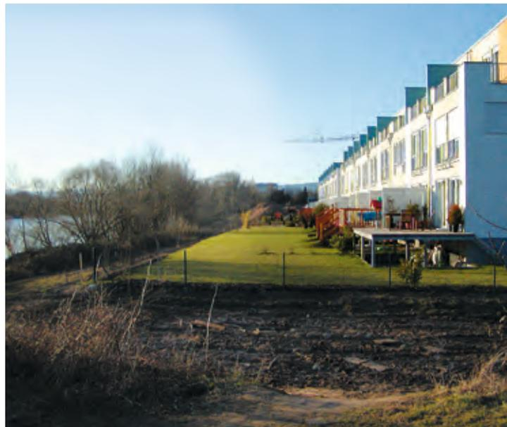
Hochwasserangepasste Bauweise mit erhöhtem Erdgeschoss
