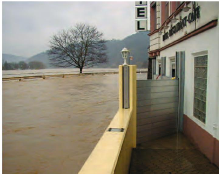
Umlaufender Hochwasserschutz mit teilmobilen Schutzelementen
