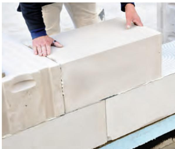
Mauerwerk aus Porenbeton
