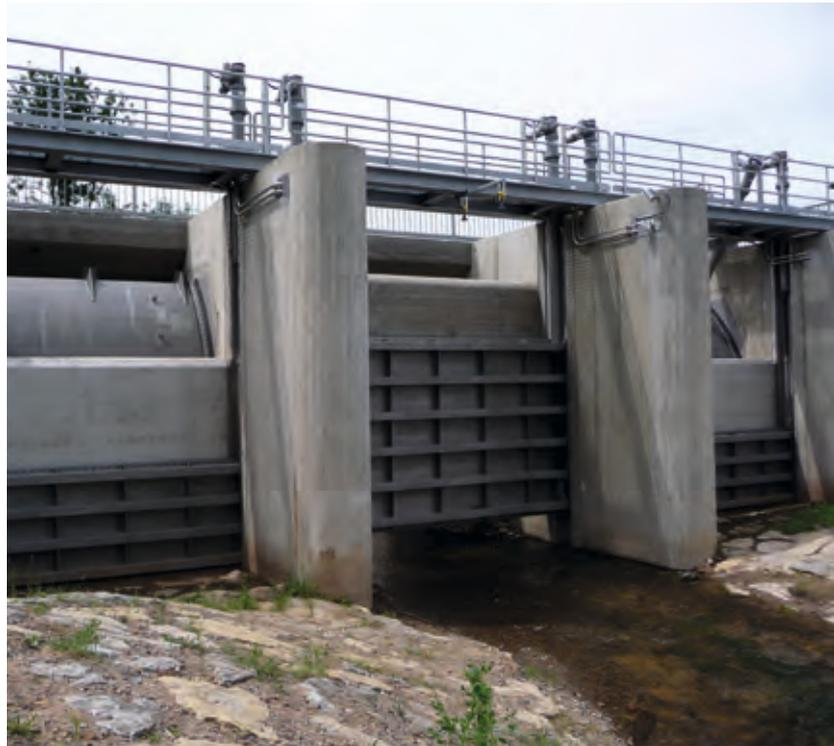
Verschlussbauwerk eines Hochwasserrückhaltebeckens
