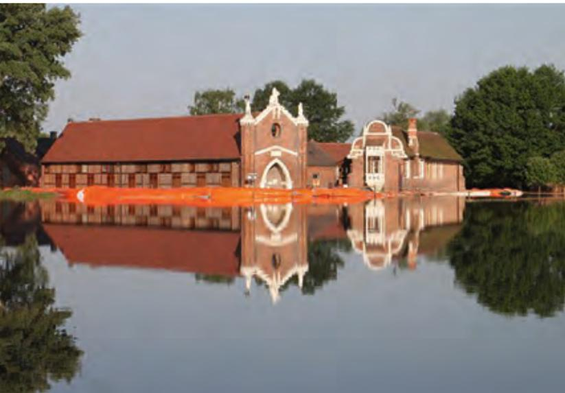
Hochwasserschutz mit mobilem wassergefülltem Schlauchsystem
