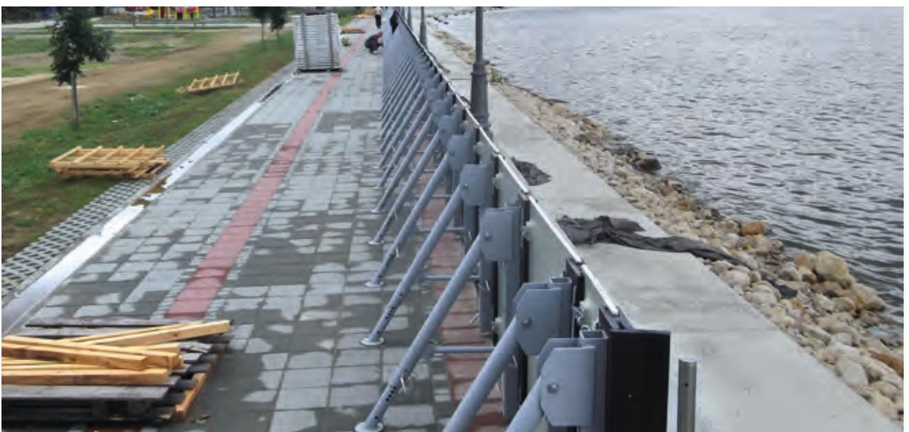
Hochwasserschutz mit Hochwasserschutzplatten aus Kunststoff
