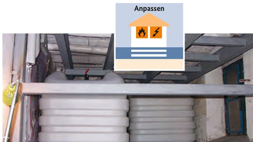
Anpassen: zum Beispiel durch Sicherung bestehender Tankanlagen
