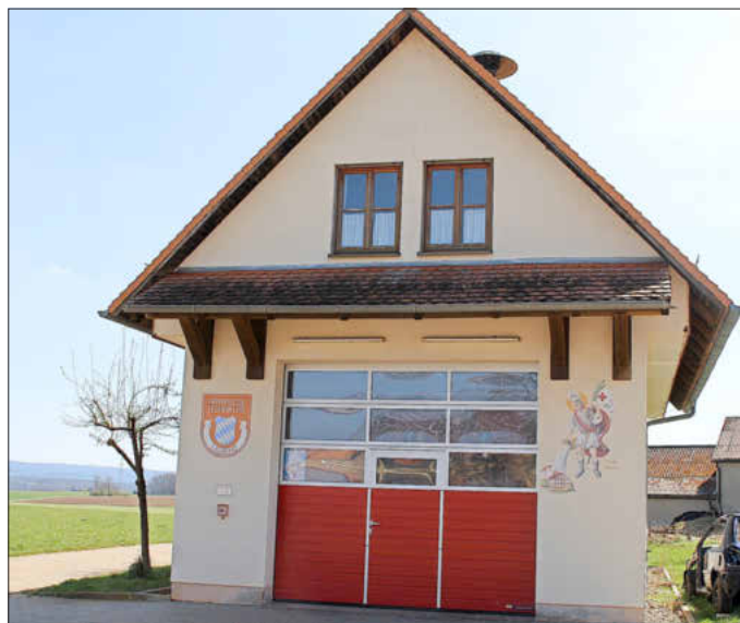
Das Feuerwehrhaus in Laubend, Foto: Gemeinde Memmelsdorf
