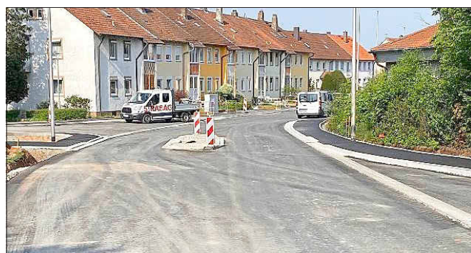
Von der Staatsstraße kommend Richtung Kapellenstraße
