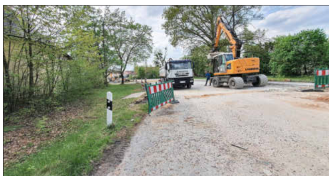
Vor der Asphaltierung, Foto: besc
