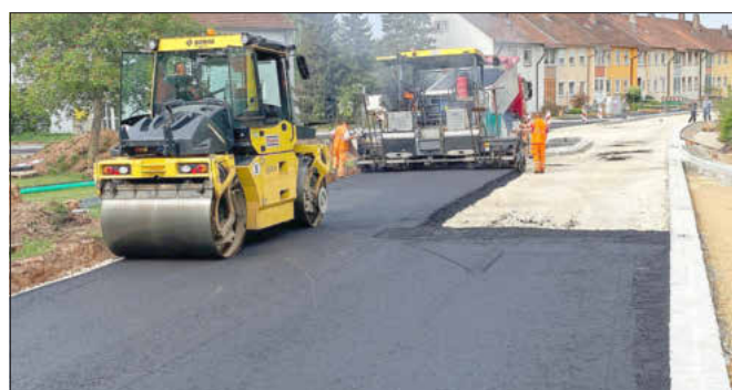
Asphaltarbeiten am 4.5.2022 (Asphalttragschicht), alle Fotos: Gemeinde Memmeldorf
