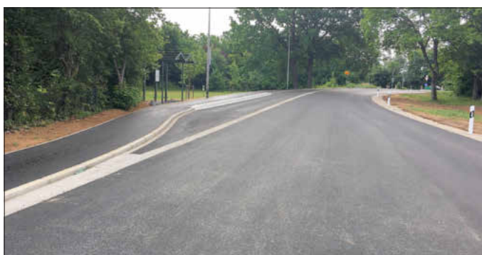
Die Bushaltestelle gegenüber der Evang. Kirche Lichteneiche noch im Rohbau
