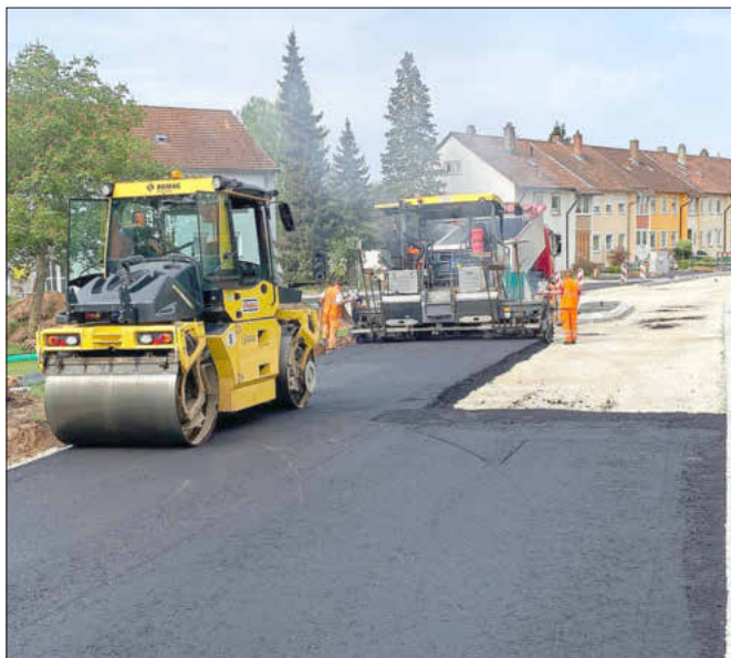
Während der Asphaltierungsarbeiten, Foto: Gemeinde Memmeldorf
